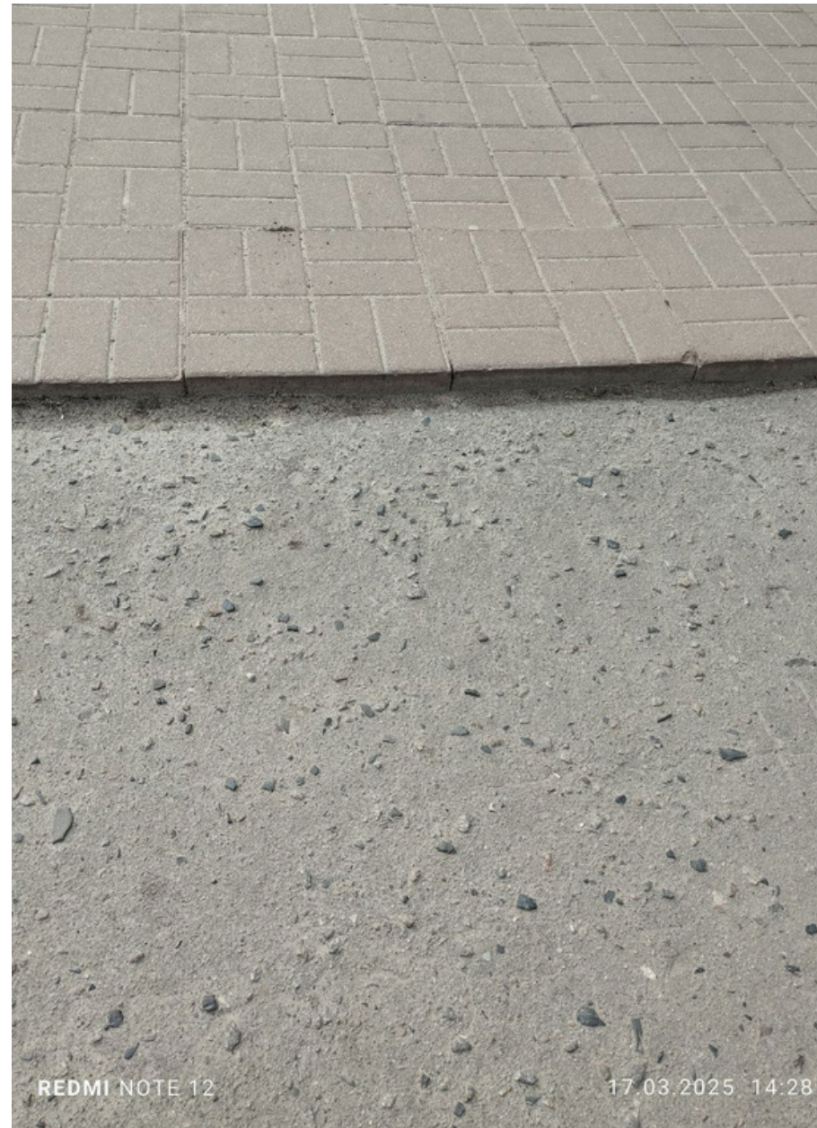
Перепад висоти між різними типами покриття
