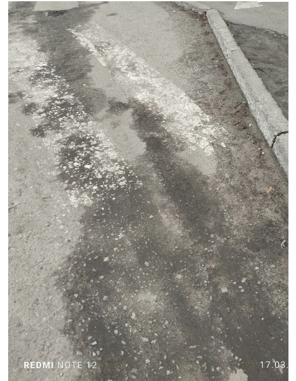
Відсутність пониження тротуарів перед пішохідними переходами
